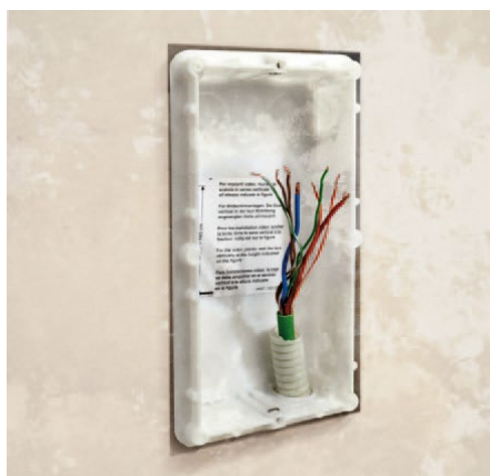
Rimuovo il posto esterno esistente
