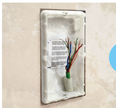
Rimuovo il posto esterno esistente
