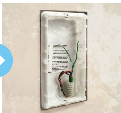
Utilizzo una coppia di cavi presenti per collegare il nuovo posto esterno
