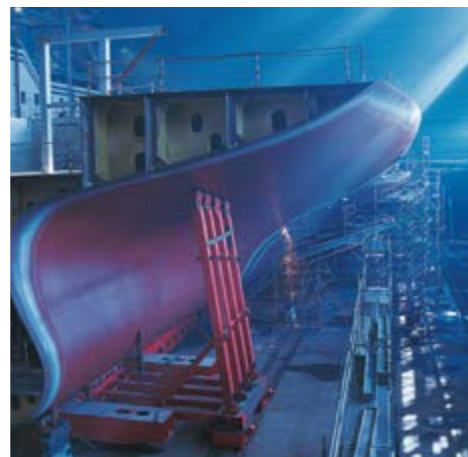
Movimentazione grandi macchine
