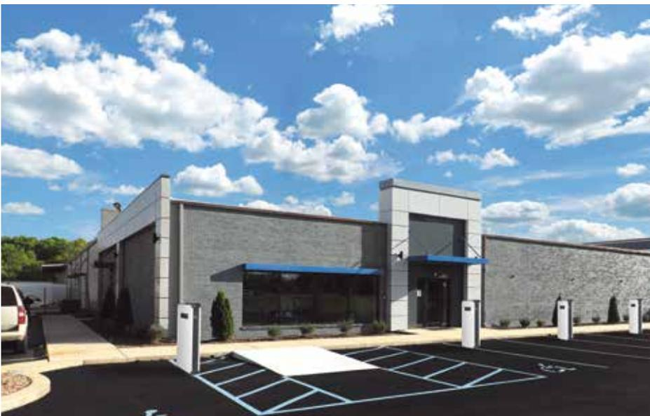
Le stazioni di ricarica da pavimento / **colonnine di ricarica**, differiscono dalle Wallbox esclusivamente per la presenza della struttura di montaggio / piantana (generalmente fornita come accessorio), ma sono identiche per quanto riguarda le dotazioni hardware e software.
