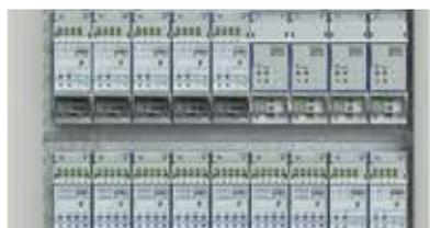
Zona accessibile all'installatore dove sono montati alimentatori, attuatori e altri dispositivi DIN (fino a 288 moduli) per il funzionamento dell'impianto MyHOME. L'installazione si completa con i pannelli di finitura bianchi.
