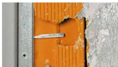
Zanca per fissaggio a muro.
